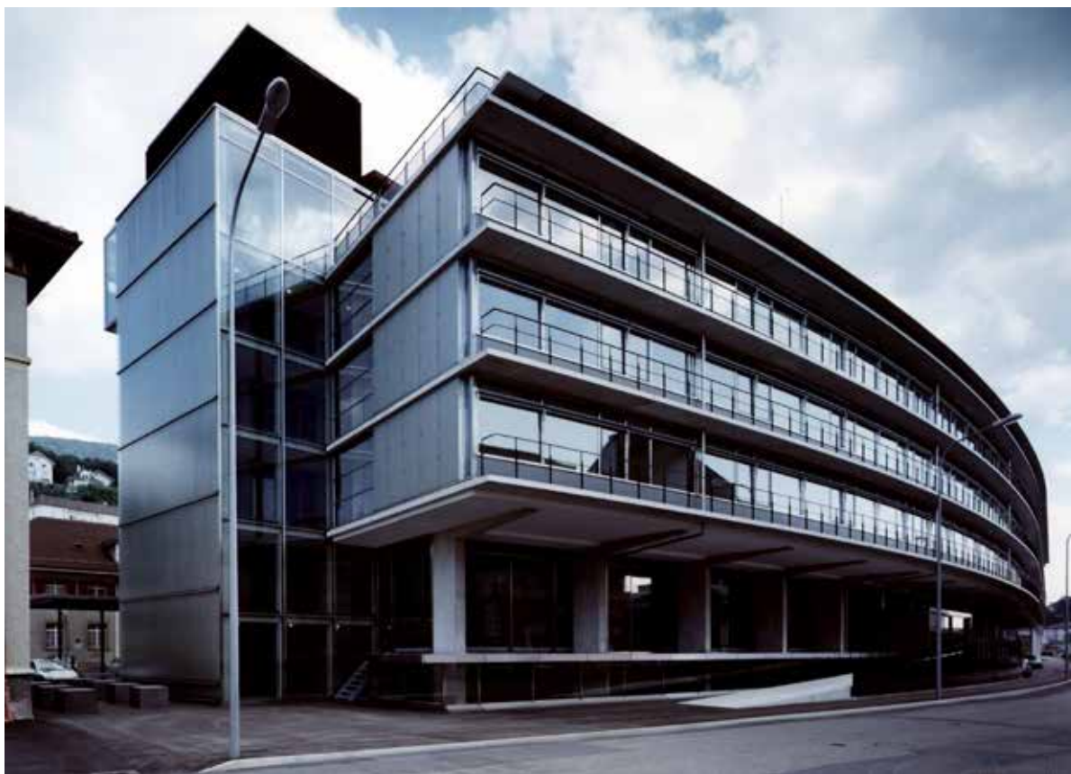
Figure 13 : Office Fédéral de Statistiques, Neuchâtel. Architectes : Bauart, Bern, 1999, ingénieurs climat : Sorane SA, Lausanne. Photo Ruedi Walti, Basel.
